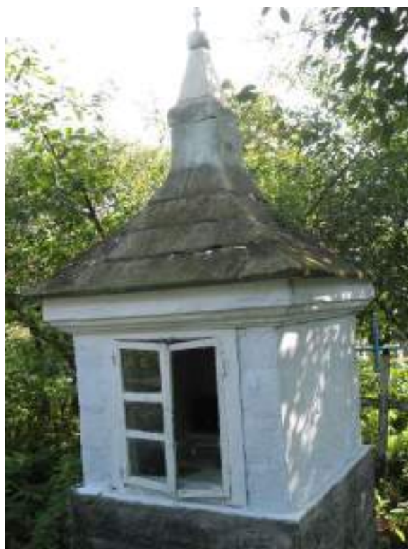
Fig. 4. Caplița – construcție protectoare a prestolului fostei biserici de lemn din satul Darcăuți, Soroca. Se află în cimitirul satului. Fotografie. Trofăilă.
