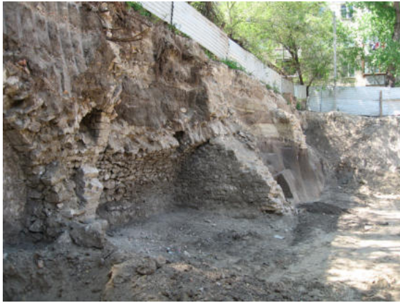
Fig.9. Pivniță medievală din preajma bisericii armenesti în proces de distrugere. Foto (de S.Ciocanu).
