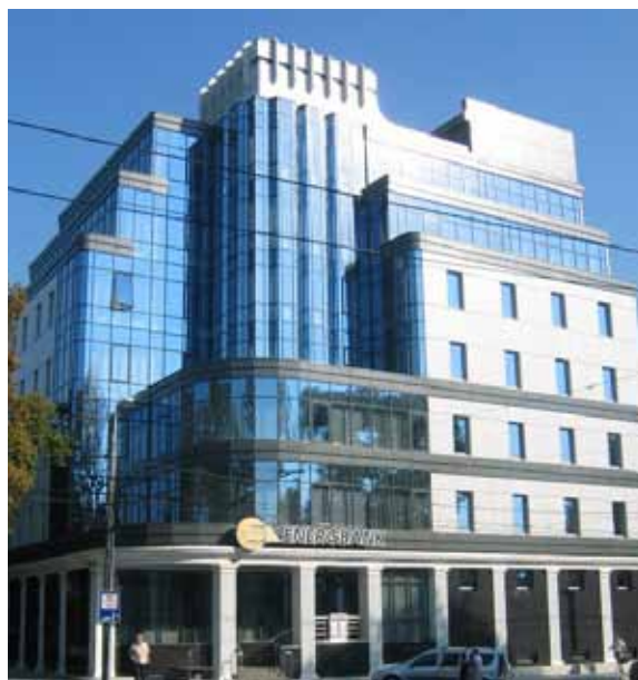
Foto 4. Clădirea pentru oficii “ENERGBANK” (str. Tighina, 23)
