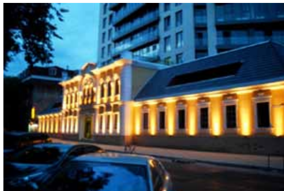
Fig.2. „Casa Krupenschi” (str. Columna, 102).
