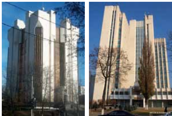
Fig.1. Clădiri administrative din Chișinău, din anii 70-80 ai secolului XX.
