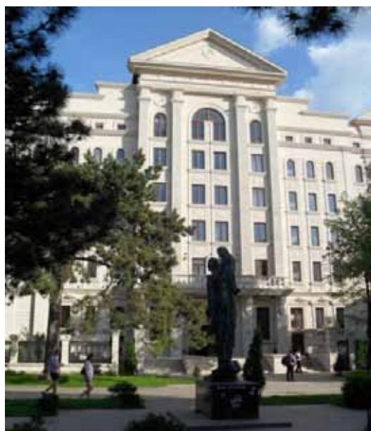
Foto 3. Clădirea pentru oficii “ASCOM Group” (str. A. Mateevici, 75)
