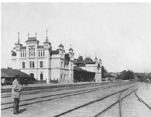
Fig. 7. Gara veche a Chișinăului. Vedere din partea căii ferate ( http://oldchisinau.md ).
