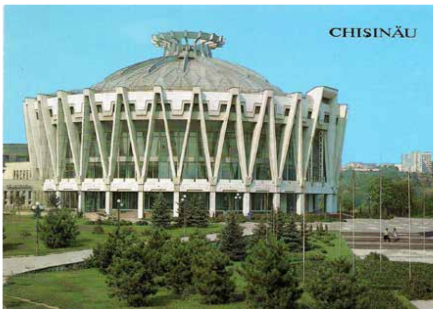
Figura 1. Circul de Stat. Arhitecți S. Șoihet, A. Kiricenکو. Vedere generală, mijlocul anilor 80 ai sec. XX ( https://goodnews.md/05/04/6896/ ; accesat 10.06.2022)
