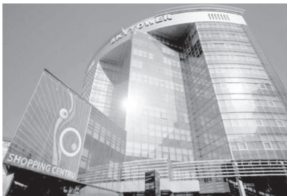
Fig. 4. Centrul internațional de business „SKYTOWER”.
