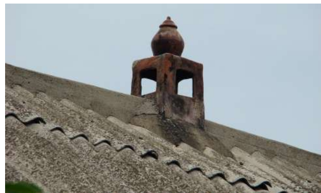
Рис. 3–5. Дымники. Глина, гончарный круг, лепка, терракота, глазурь. Село Перебыкивцы Хотинского р-на Черновицкой обл., 1930–1940 гг.
